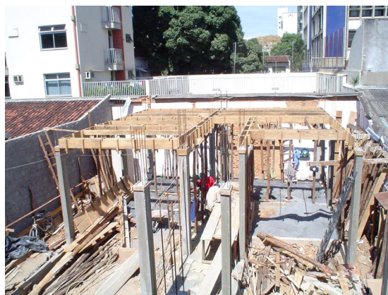
... durante as obras
