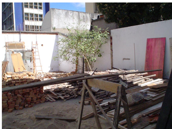
agosto de 2006 - início das obras
