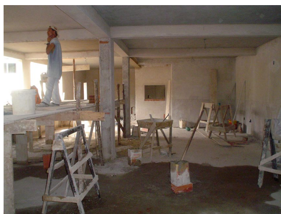
Construção do restaurante sendo finalizada
